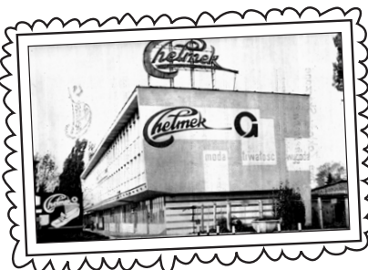
Biurowiec byłych Południowych Zakładów Przemysłu Skórzanego „Chelmek” przy Placu Kilińskiego w Chełmku.
